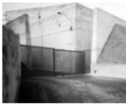
LA ZONA DEI SERBATOI IDRICI COMUNALI
